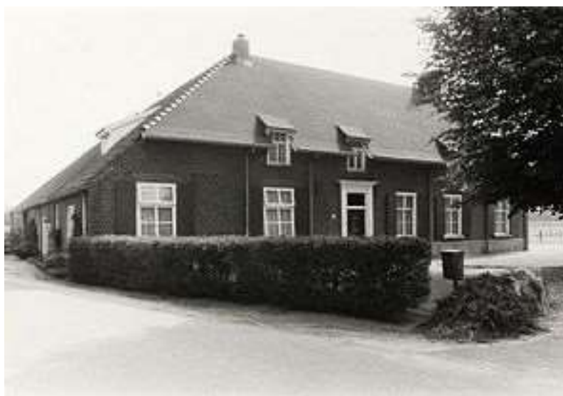
Boerderij "de Romein/De Oostermee" te Groot-Linden, Kerkstraat, na restauratie (zie Deel I sub IV u en V uuu).
